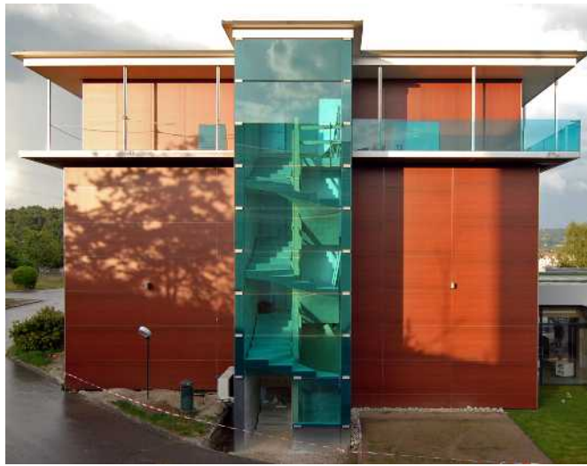
نمای شمالی ساختمان با پلکان جدید بتن مسلح.
