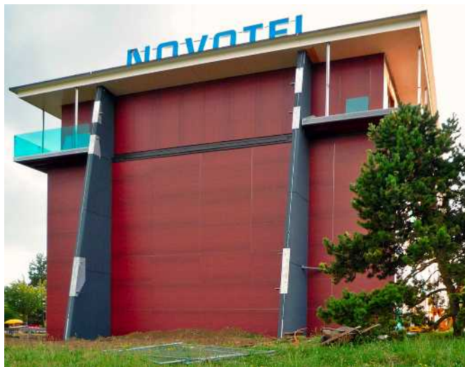
نمای جنوبی ساختمان با پشت‌بندهای بتن مسلح جدید مثلی.
