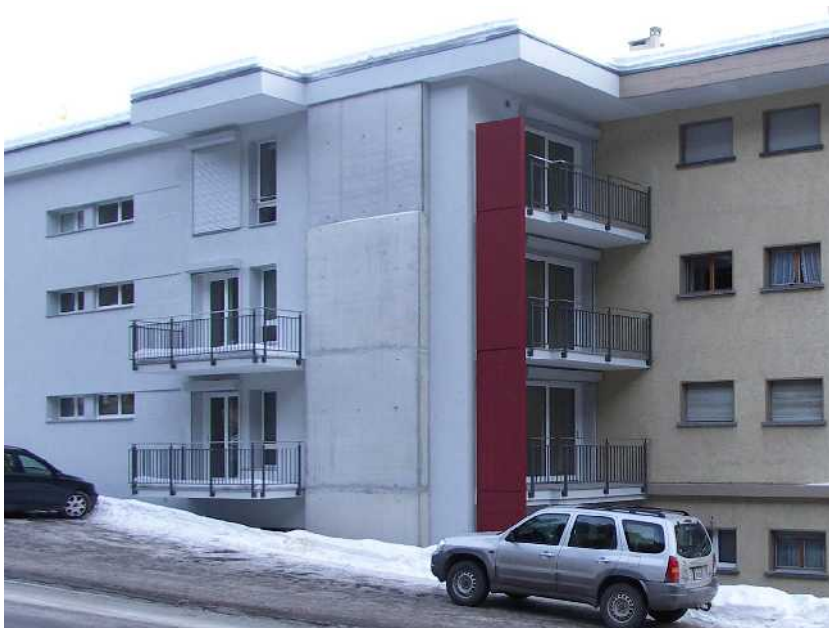
نمای شمالی ساختمان و دیوار پیرامونی بتن مسلح جدید.
