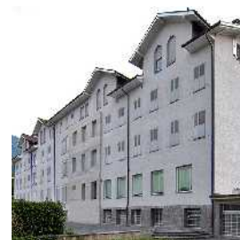
ساختمان از نوع بنایی غیرمسلح (مثال ۷: مدرسه‌ای در شهر مونتی)
