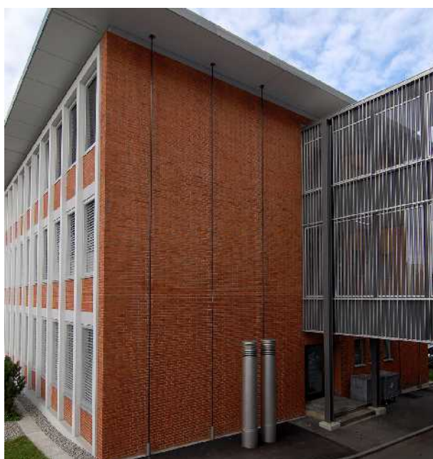
تقویت نمای شمالی با استفاده از میله‌های کششی الیاف کربن.
