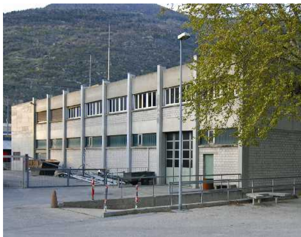
نمای طولی پشت ساختمان ایستگاه که توسط دیوار بتن مسلح سازه‌ای در منتهی‌الیه چپ تقویت شده است.
