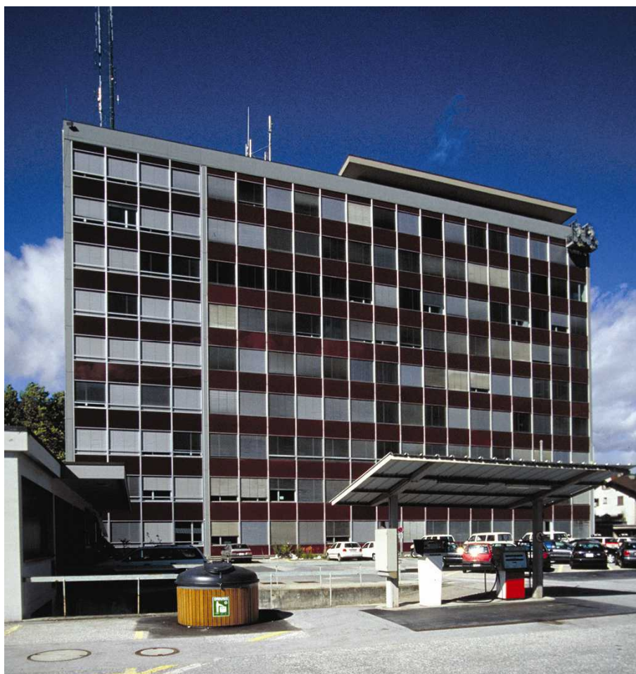
نمای طولی ساختمان اداره پلیس. چهار پنجره آخر در منتهی‌الیه سمت چپ در هر تراز، بخش توسعه را نشان می‌دهد.
