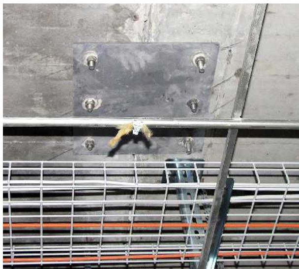
انسداد درزهای انبساطی در کف طبقات با تعبیه ورق‌های فولادی در هر دو وجه آنها.
