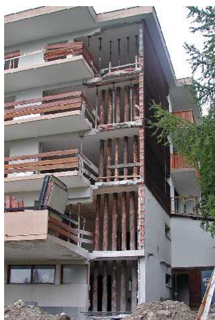
عملیات اجرایی در کنج جنوب شرقی ساختمان.
