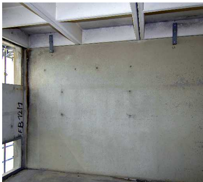
تسمه‌های فولادی تقویتی برای برقراری اتصال بین دیوارها و دال سقف.
