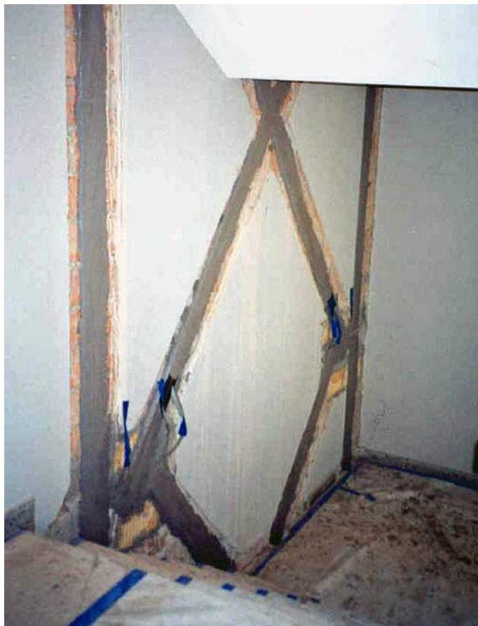
تقویت دیوارهای بنایی در اطراف پلکان با نوارهای CFRP.
